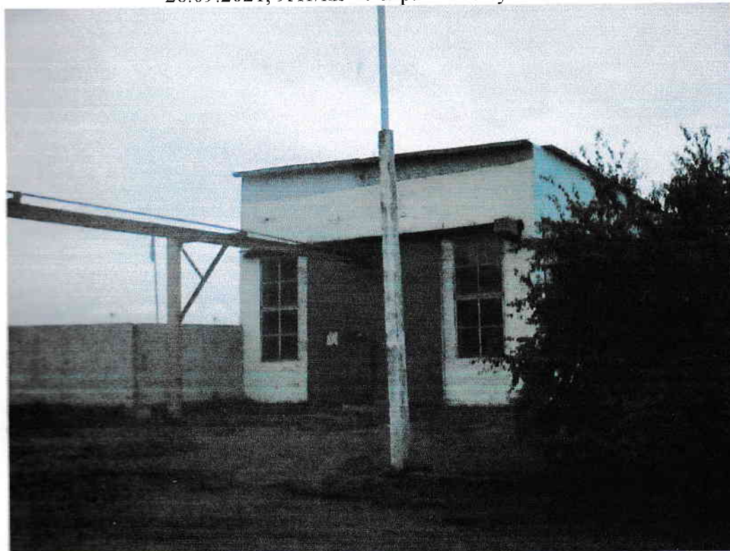
28.09.2021, 9А1/кп – покрасочный участок
